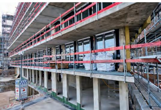
Die Balkone wurden mit einigen wenigen Ausnahmen aus Betonfertigteilen erstellt.
