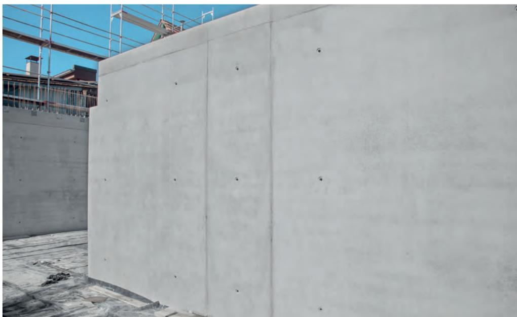
Homogene Oberflächen und ein einheitliches Fugen- und Ankerlochbild
