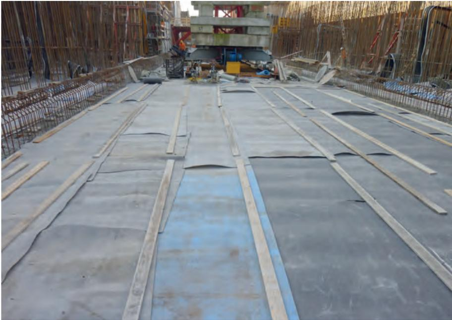
Bild 3: Betonnachbehandlung mit zusätzlichen Dämmmatten
