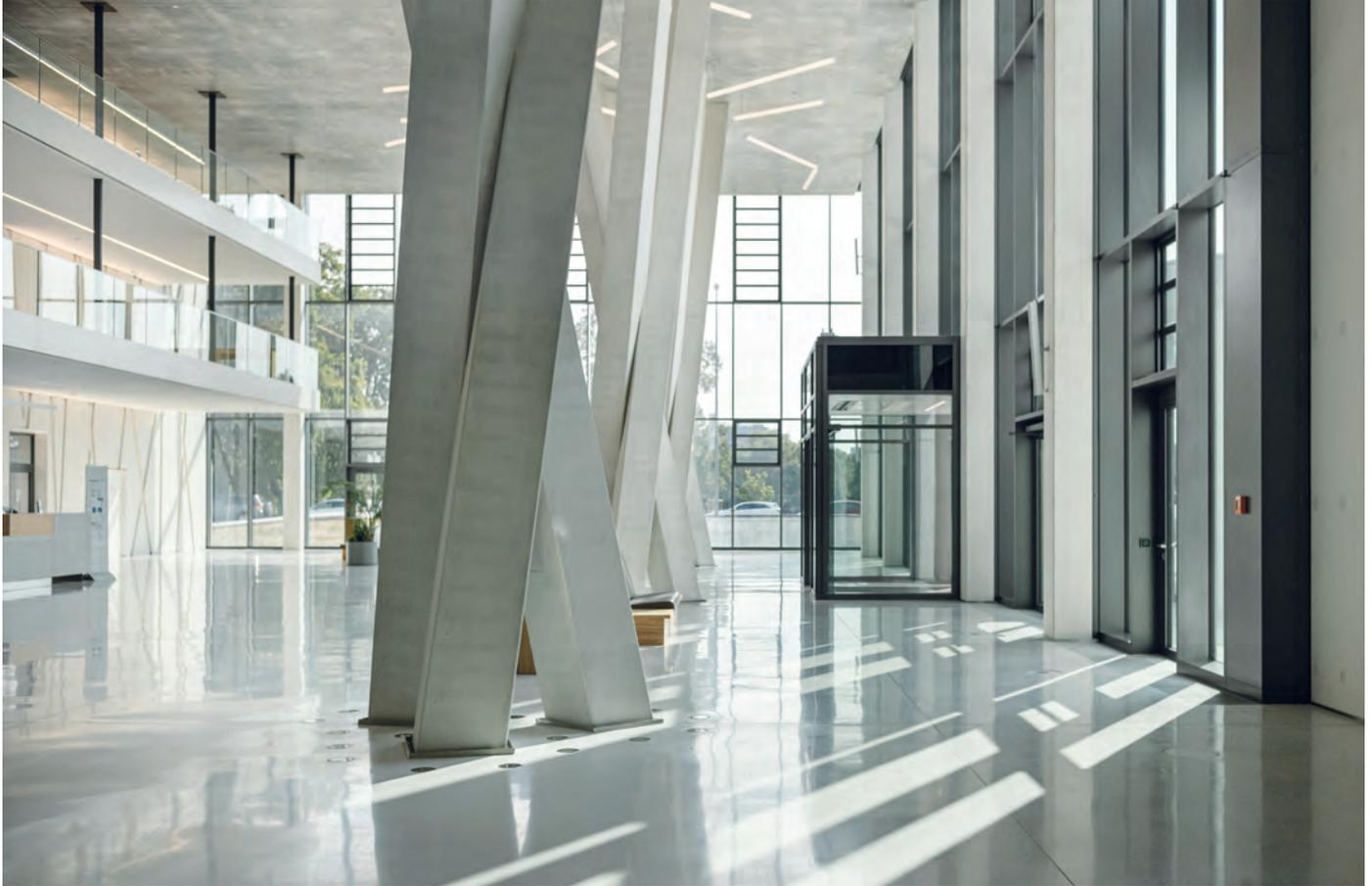
Bild 4: Für die 11 m hohen Baumstützen des Neubaus der Hauptverwaltung der HeidelbergCement AG wurde für Konstruktion und Optik ausgereizt, was in der Betontechnik derzeit möglich ist.
