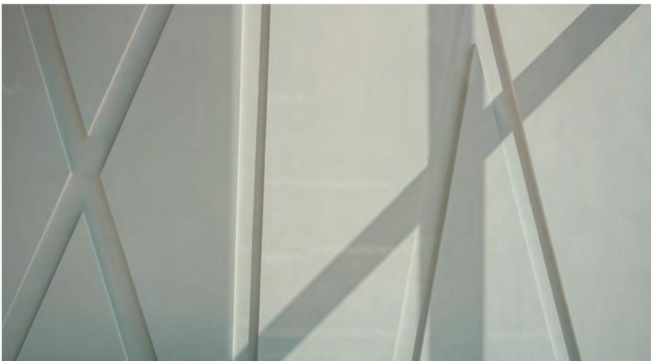
Bild 5: Die Feature Wall, eine dekorative Betoninstallation, setzt sich aus 21 Einzelelementen mit Maßen von bis zu 4 m x 2,50 m zusammen, die an manchen Stellen nur 4 cm dick sind. Jedes Element stellt ein Unikat dar. Die „Feature Wall“ erforderte die Herstellung 21 individueller Schalungen mit höchst anspruchsvollen und komplexen Geometrien.
