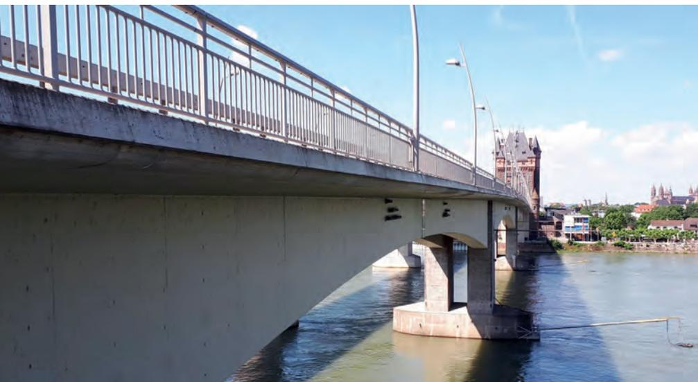
Die zweizellige Spannbeton-Hohlkasten-Konstruktion hat eine Hauptstützweite von 114,2 m. Foto: BInGK
