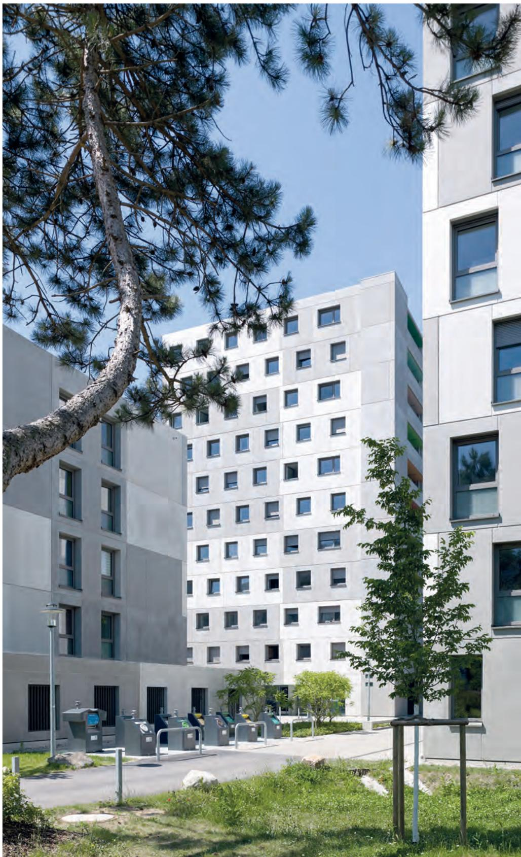
Die Fassadenraster ist schachbrettartig in vier verschiedene Oberflächenstrukturen gegliedert.
